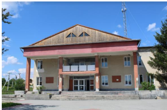
Figura 7. Casa de cultură, comuna Hîrtop
